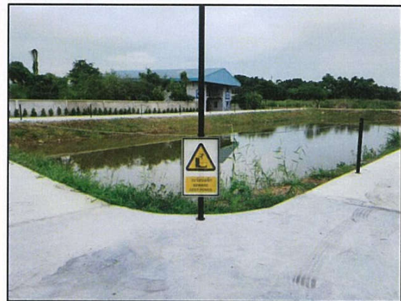
รูปที่ 2-15 การติดตั้งราวกันตก พร้อมป้ายเตือนระวังตกบ่อ
